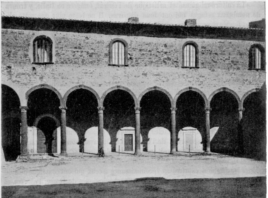
Le Portique de Sangallo.
